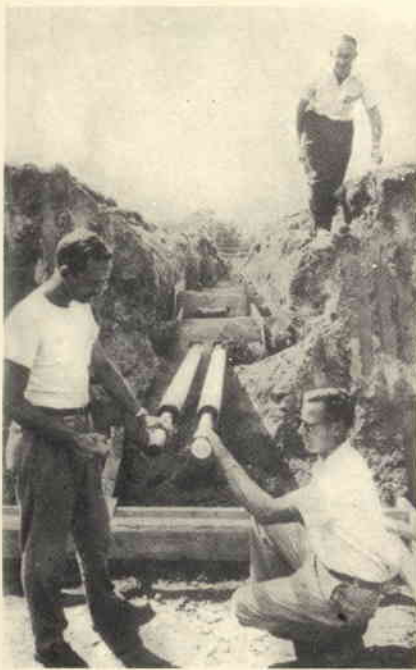
Fig. 18 - Deposizione di guide d'onda avvenuta nel 1956 da parte dei tecnici della Bell, aventi una lunghezza di 3 km ed una struttura elicoidale.
